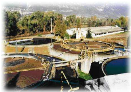
Depuratore di Costa Volpino
